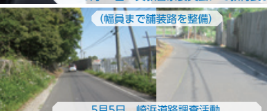
5月5日 輪浜道路調査活動 (幅員まで舗装路を整備)
